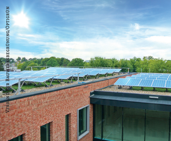
In Brunssum (NL) wurde das 4.000m 2 große Dach des Gesundheitszentrums Sanoforum extensiv begrünt und mit einer Photovoltaikanlage, deren Aufständerung nur durch die Auflast befestigt ist, ausgestattet.
